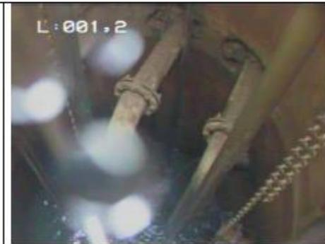
Photo 2 : Idem photo 1, avec au centre de l'image les deux autres colonnes d'exhaure.
