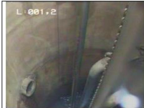
Photo 1 : Vue intérieure de l'ouvrage avec à gauche de l'image, le tuyau d'évacuation du trop-plein. Au centre, une colonne d'exhaure.
