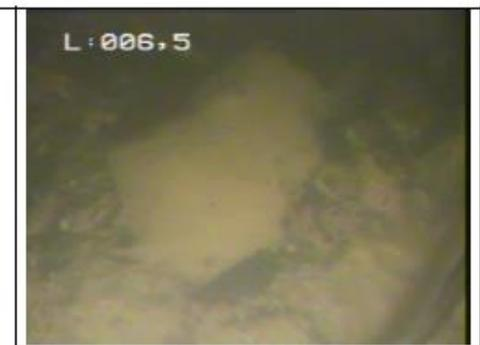
Photo 12 : Fond de l'ouvrage atteint à -6,60 m/repère. La caméra repose sur des éléments plus grossiers (inspection côté route D3)
