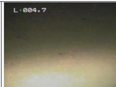
Photo 4 : Paroi de la buse béton de diamètre 2000 mm. Elle est couverte d'un léger dépôt bactérien et de vase.
