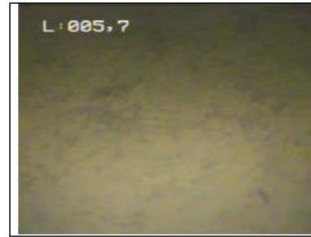
Photo 7 : Paroi des buses béton de diamètre 2000 mm recouverte d'un léger dépôt bactérien.
