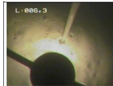
Photo 11 : Fond de l'ouvrage atteint à -6,50 m/repère de mesure. La caméra repose sur un dépôt de fin sédiment (inspection côté rivière).
