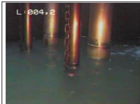
Photo 3 : Avant de pénétrer dans l'eau, on observe deux colonnes d'exhaure en inox et également la turbidité de l'eau.
