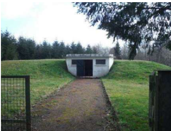
Réservoir de 450 m³
