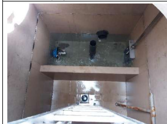
Source de Belle Fontaine – Intérieur captage
