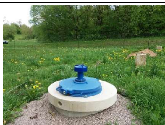
Captage de Belle Fontaine refait à neuf
