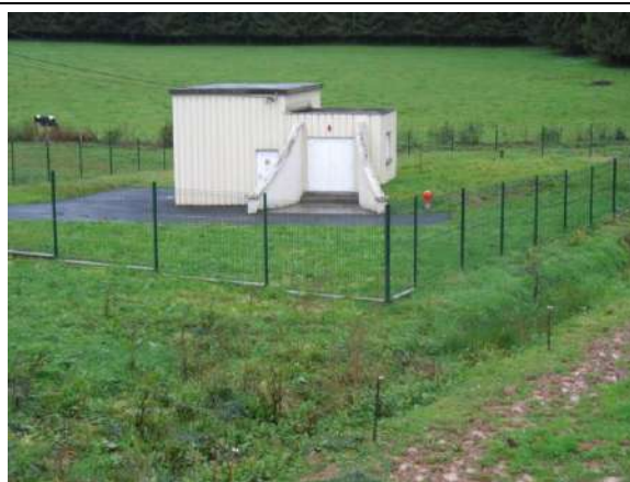
Station de traitement et de pompage
